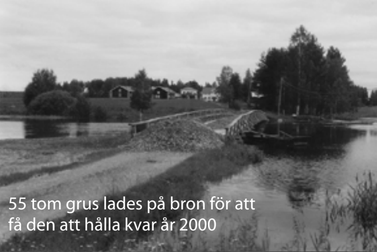
Bild från översvämningen år 2000 där vattenståndet var ca 2 meter över det normala
