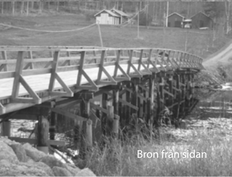
Den nyrenoverade bron år 2010
